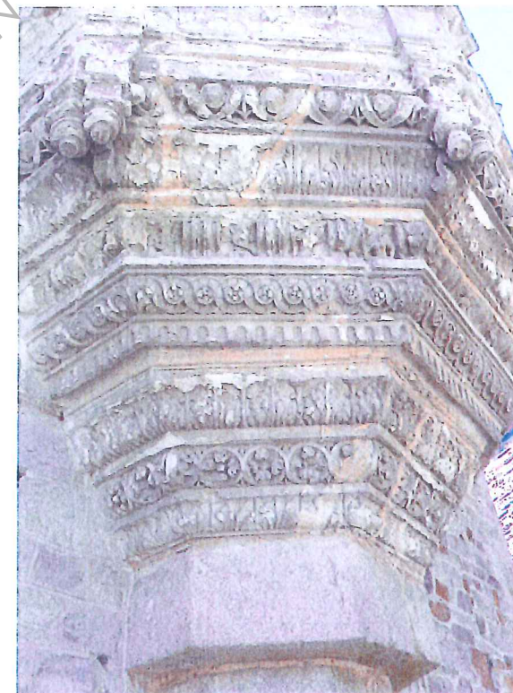
Parement de la tour en partie dégarni
